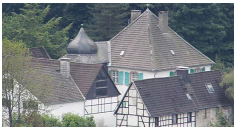
Abb. 05: Dachlinie auf Ahlhausen vom Hohenstein aus
